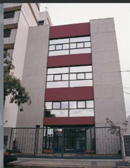
Planta de Almacenamiento
